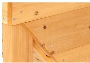
4. Coloque las tablas finales en forma de V a la Vegtrug. Ellos deben quedar bien ajustados y correctamente alineados con los extremos de los aparadores. En esta etapa, fíjalos con un tornillo en cada lado para mantenerlos en su lugar.
